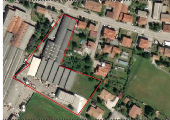
Inquadramento fotografico, fuori scala
