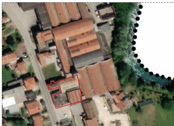
Inquadramento fotografico, fuori scala
