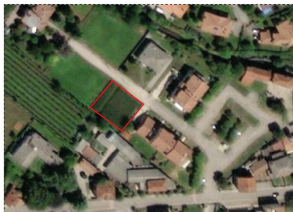
Inquadramento fotografico, fuori scala
